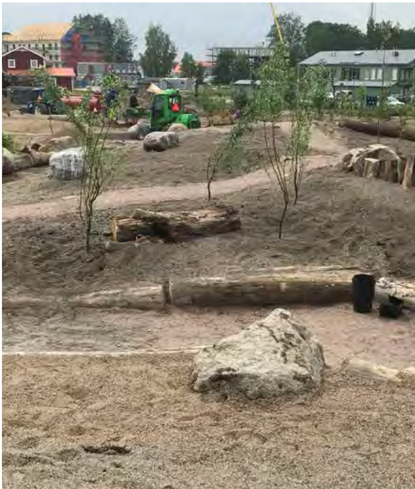
Upphöjda växtbäddar i Hjälmaviksparken förbättrar dränering och syreförhållanden.
